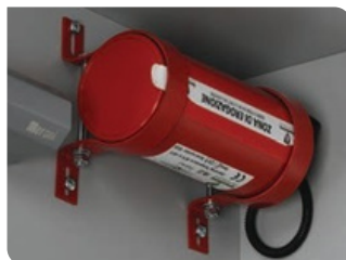
Gaśnica z certyfikatem: EN 15276:2019; ISO 15779:2011 NFPA 2010; Cistec kod produktu: 103-2-WCE-1015
