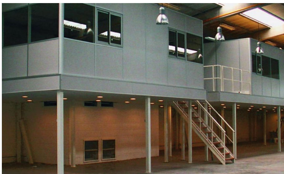
ANTRESOLE PRZEMYSŁOWE ZAPEWNIĄCE DODATKOWĄ PRZESTRZEŃ ROBOCZĄ
